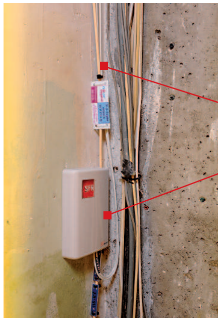
Vue d'une gaine technique ouverte
