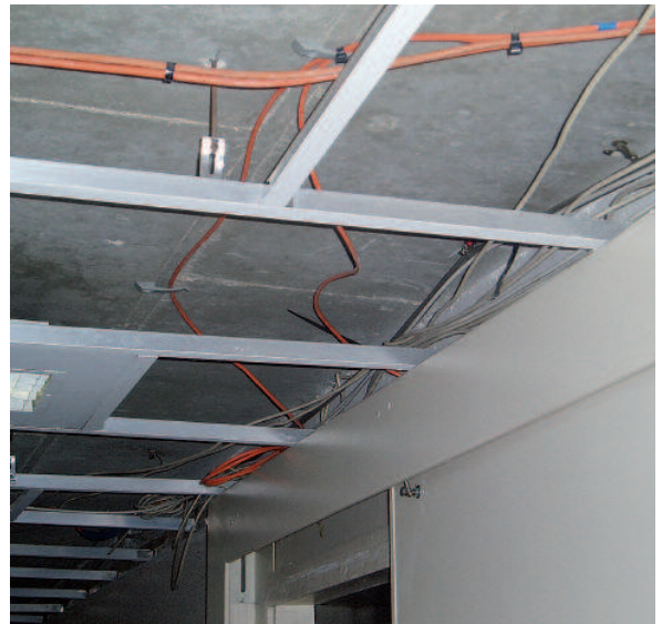
Passage de la fibre à travers des faux-plafonds
