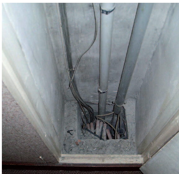
Passage à travers les fourreaux reliant la gaine technique aux appartements
