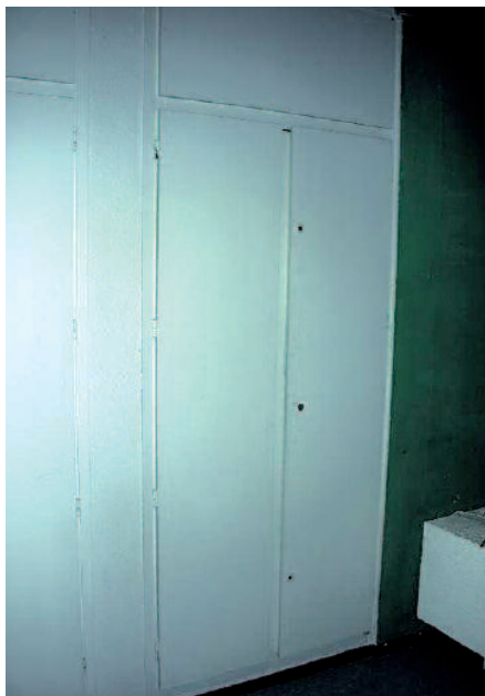
Vue d'une gaine technique fermée
