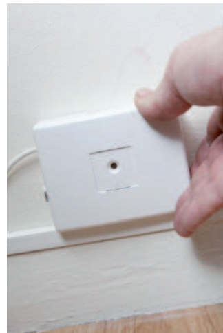
Prise terminale optique à l'intérieur du logement.
