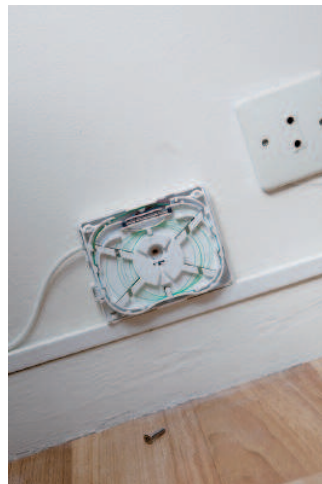
Prise terminale optique à l'intérieur du logement.
