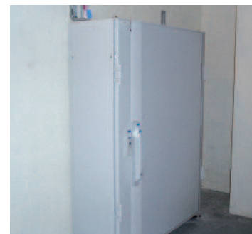
Exemple pour un immeuble de plus de 96 logements : une armoire d'environ 90 x 120 x 30cm à 90 x 240 x 30cm.
